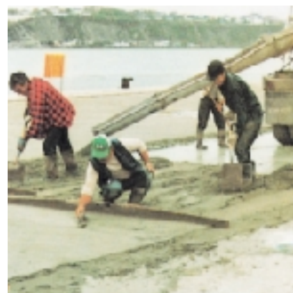
Einbau eines mit PLANICRETE vergüteten Betons im Außenbereich
