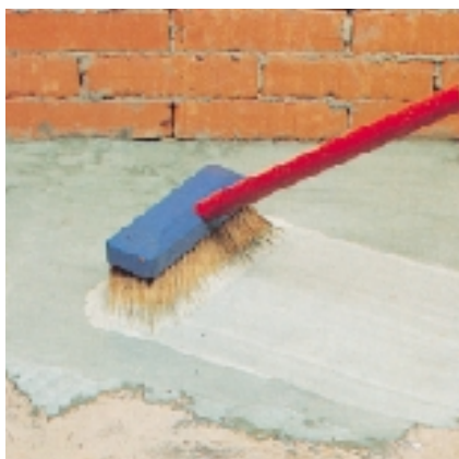
Gruntowanie emulsją PANICRETE w celu polepszenia przyczepności
