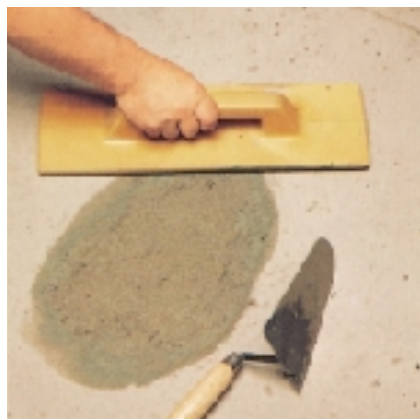
Naprawa posadzki i jej wyrównanie
