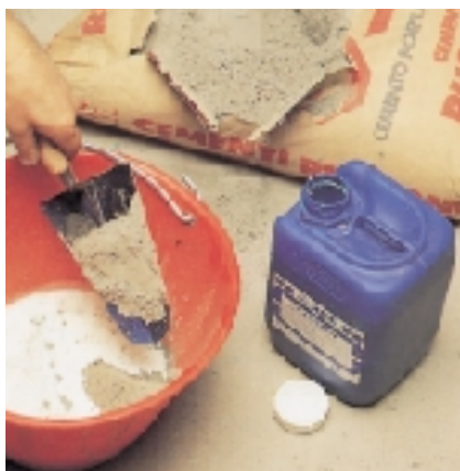
Ulepszanie zaprawy emulcją PLANICRETE
