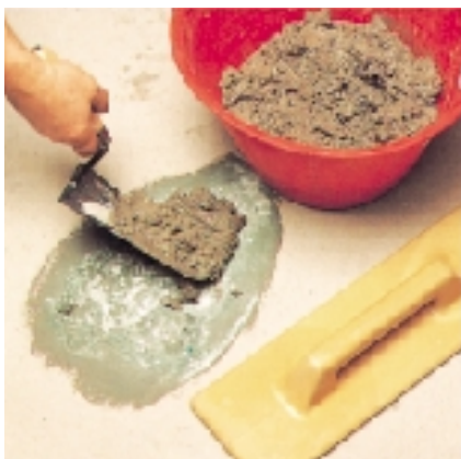
Prace naprawcze za pomocą zaprawy ulepszonej emulsją PLANICRETE
