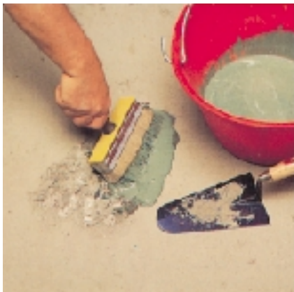
Gruntowanie emulsją PLANICRETE w celu polepszenia przyczepności.
