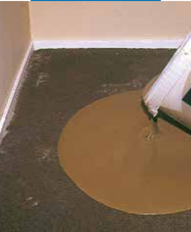
Wylewanie masy Novoplan 21 na podłoże
