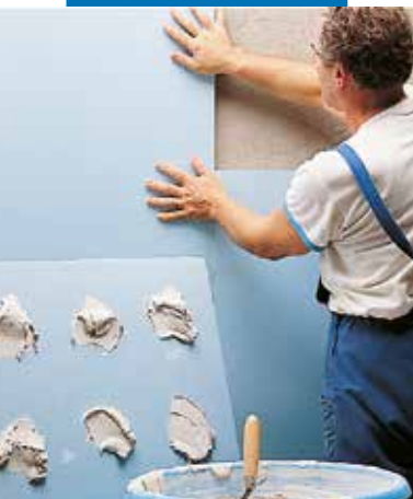
Montaż płyt styropianowych przy użyciu Keraflex białego
