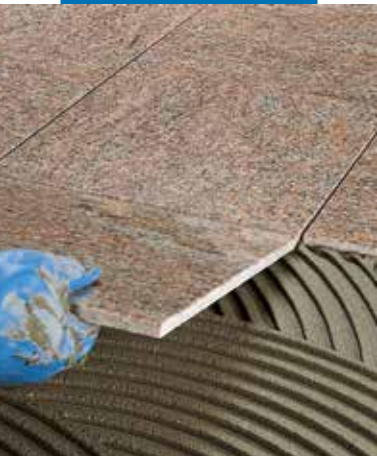
Układanie posadzki z marmuru polerowanego
