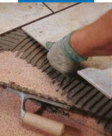
Montaż płytek na istniejące podłoże lastrykowe
