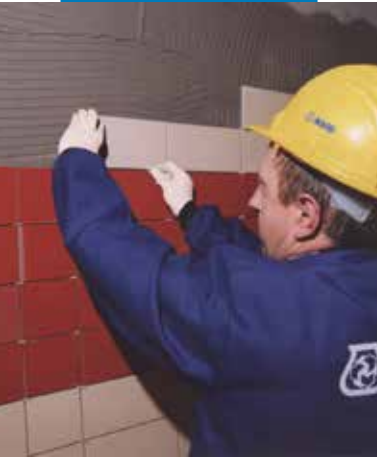
Układanie płytek ceramicznych na powierzchniach pionowych
