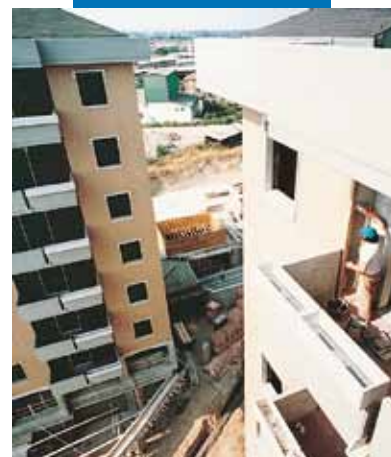
Montaż płytek na zewnątrz
