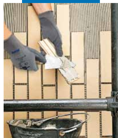
Zaprawą należy pokryć całą powierzchnię płytki
