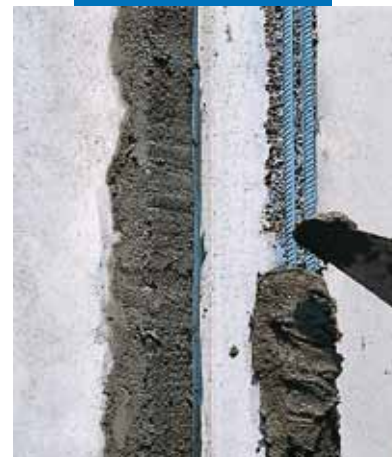
Nakładanie zaprawy przy użyciu kielni
